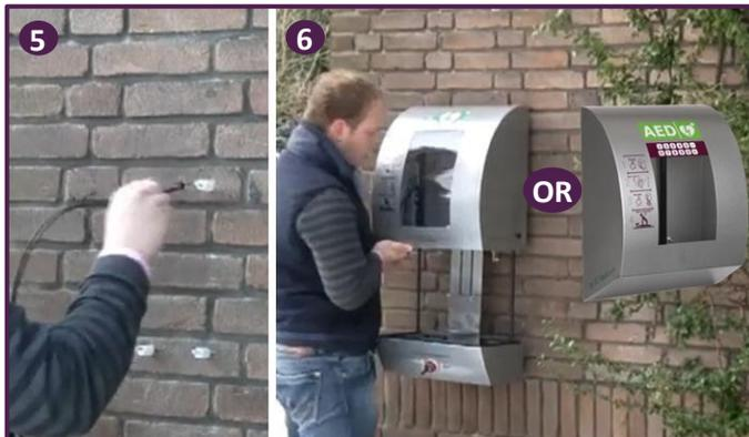
5. Stromkabel durch das Loch einführen
